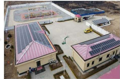
东海光伏发电项目
